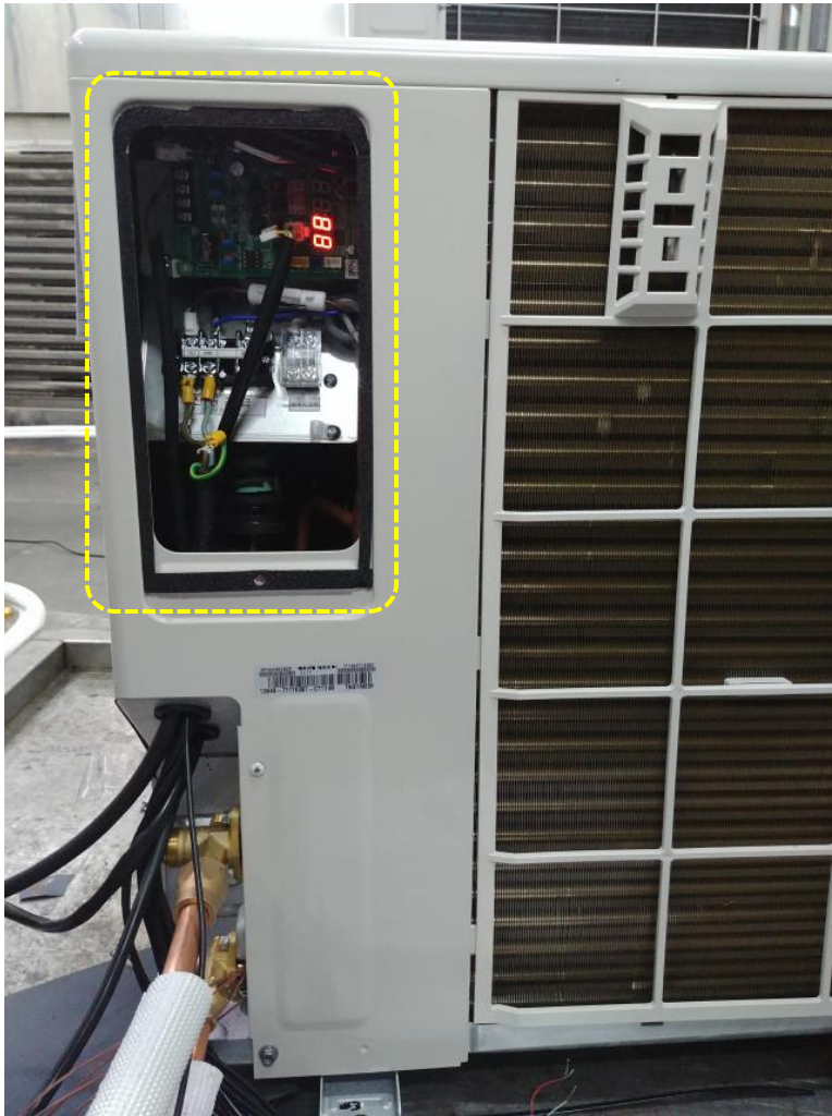
자동 주소설정 (Auto addressing) 1분 진행 이후 7 세그먼트에 '88' 표시 → 사전점검 운전 진행시 자동 실행됨
